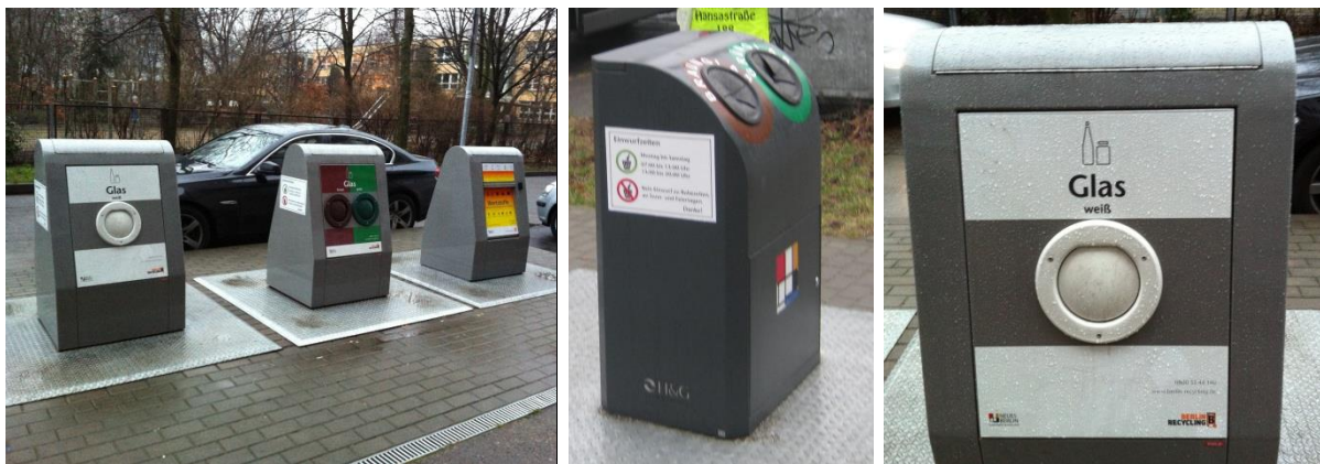
Abbildung 8: Stellplatz und Beschriftung von Unterflursystemen
